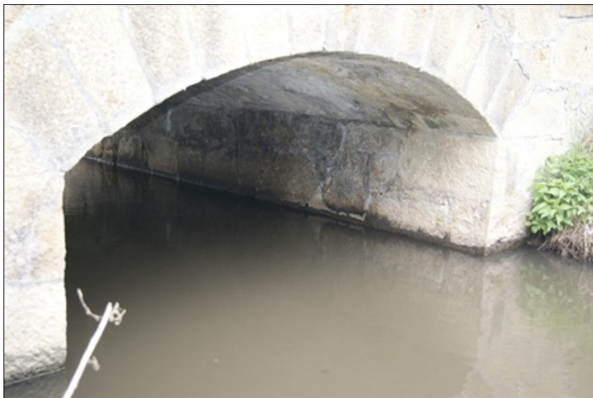
Pohled na líc levobřežní opěry a podhled NK
